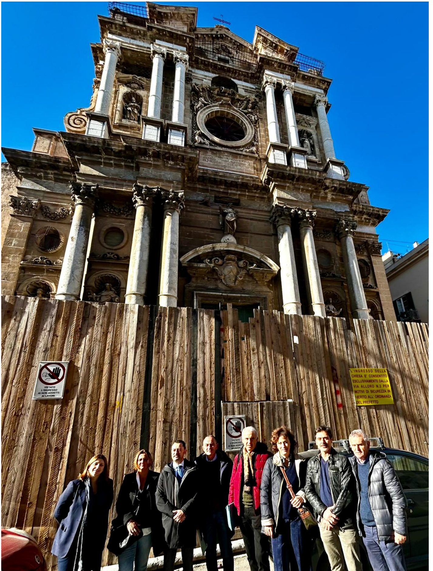
Hanno preso il via questa mattina i lavori di somma urgenza del prospetto della chiesa di Santa Maria della Pietà , nel quartiere Kalsa di Palermo, appartenente al Fondo edifici di culto (Fec), gestito dal Ministero dell'Interno.
