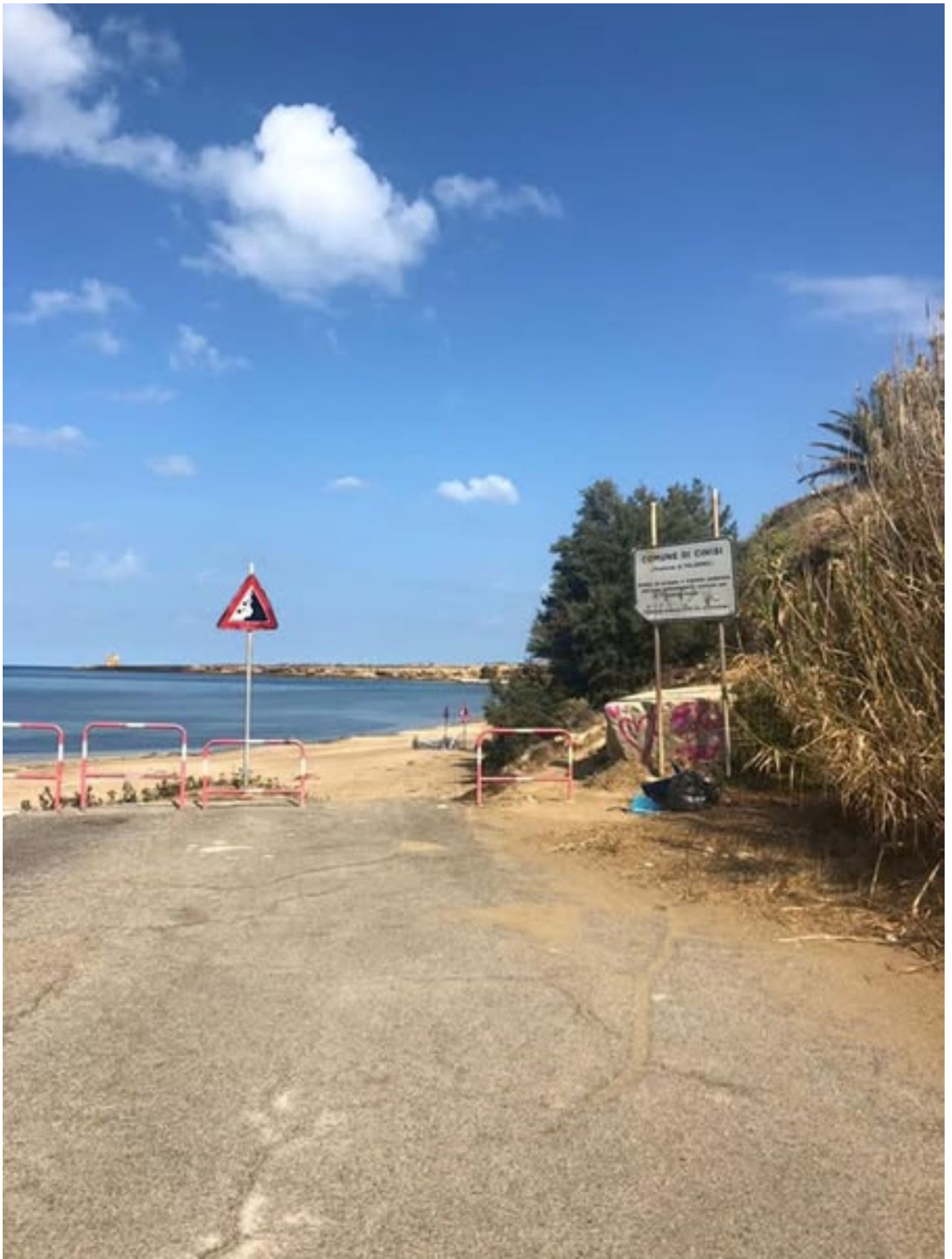
Pronta a rinascere la spiaggia di Magaggiari al confine fra Cinisi e Terrasini per anni parzialmente inaccessibile a causa del rischio di frane dal costone roccioso ma ugualmente frequentata da
